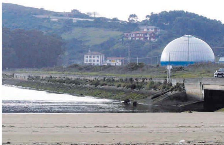
La depuradora de Maqua, vista desde Zeluán.
