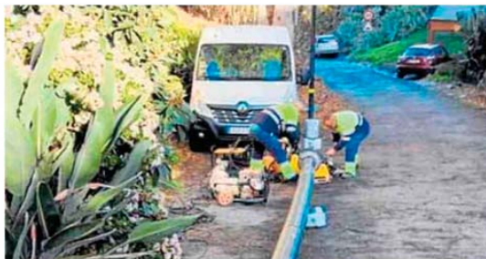
Tareas de renovación de la red de saneamiento del Caserío de Bandama. c7
