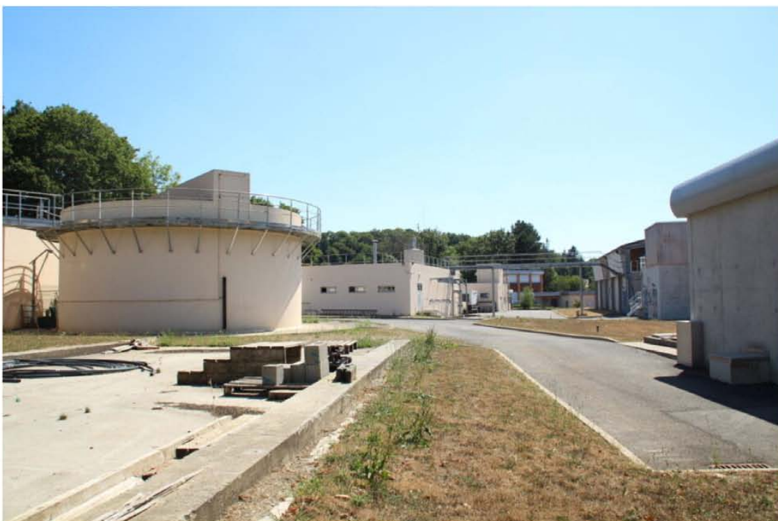
Lusine de traitement de leau potable du syndicat du Lié, au Pont-Querra en Plémet, près de Loudéac (Côtes-dArmor). ©Yann SCAVARDA
